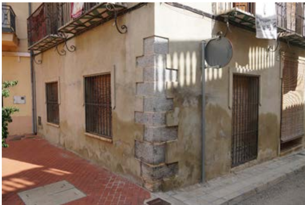
8. FOTO 4. Vista detalle canto de sillares 2
