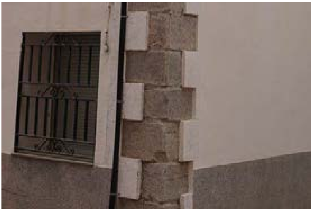
8. FOTO 4. Detalle esquina piedra
