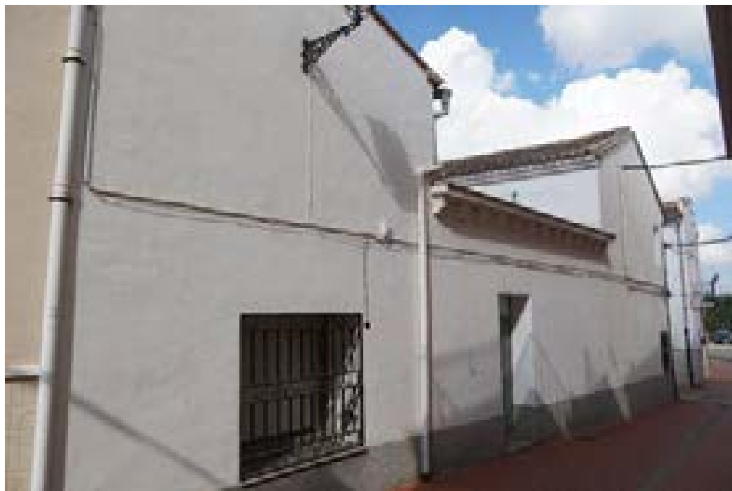
8. FOTO 5. Vista fachada recayente a Calle Cups
