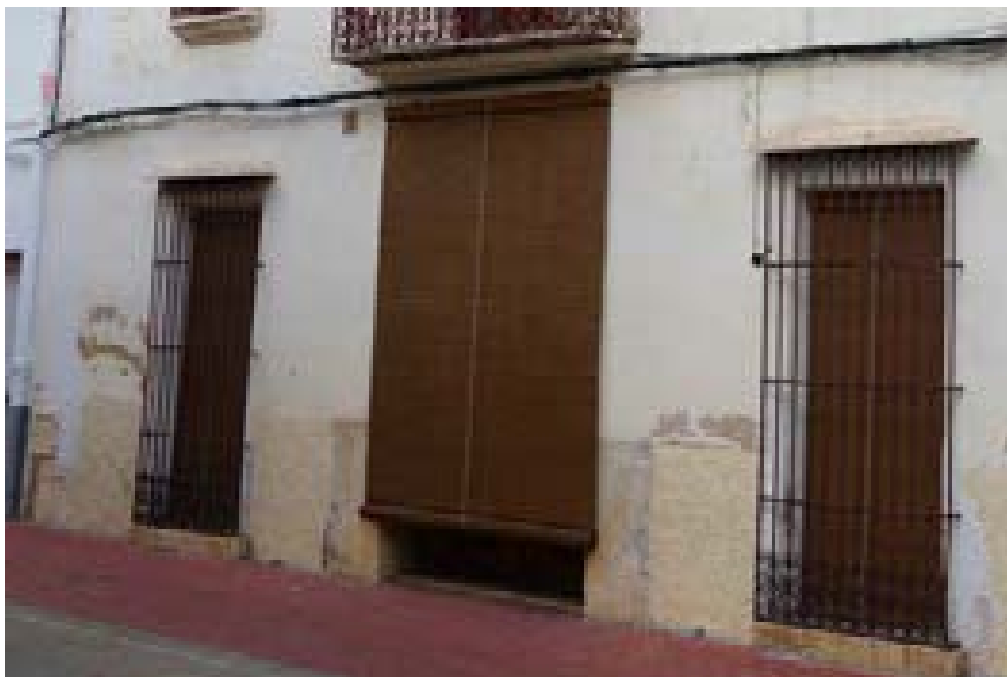
6. FOTO 2. Vista detalle planta baja
