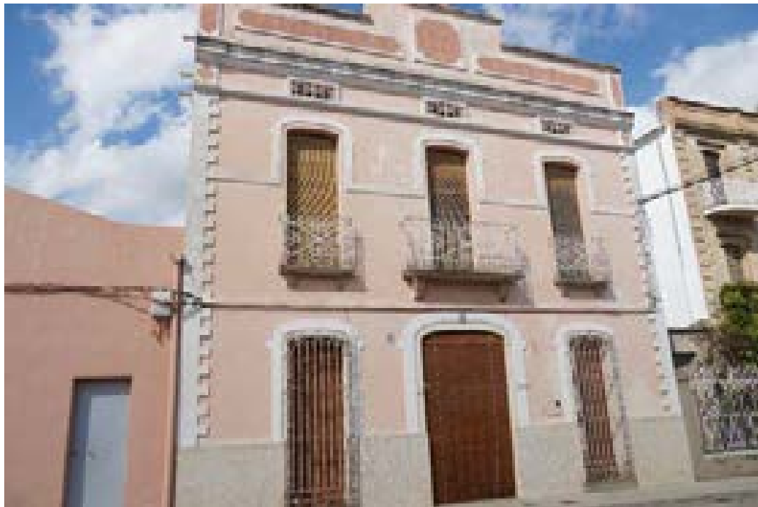
6. FOTO 2. Vista lateral del edificio
