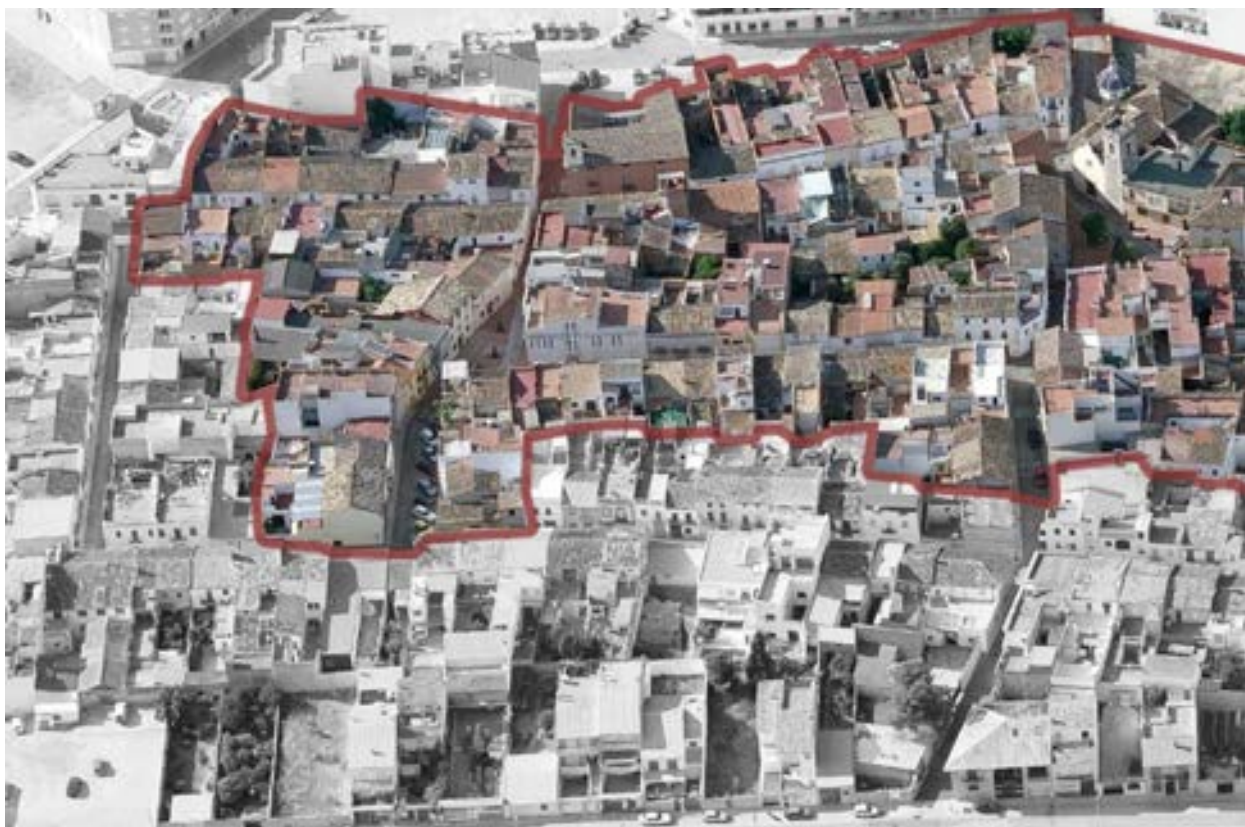
Vista panorámica de la delimitación del NHT-BRL, zona occidental.
