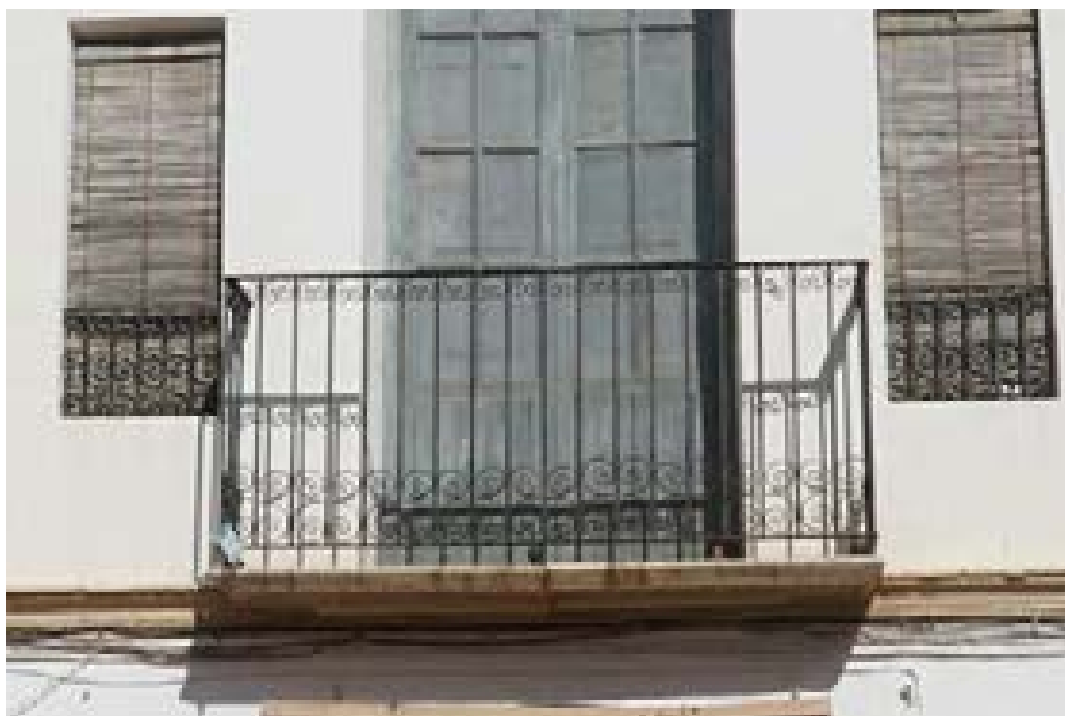
8. FOTO 4. Losas de piedra en balconada de planta primera
