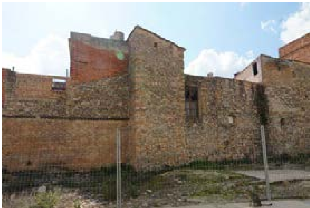
6. FOTO 2. Fachada principal del edificio
