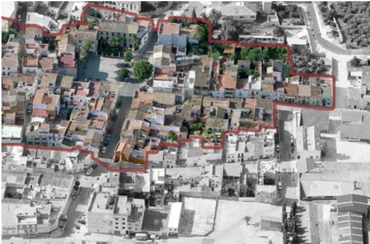
Vista panorámica de la delimitación del NHT-BRL, zona oriental.
