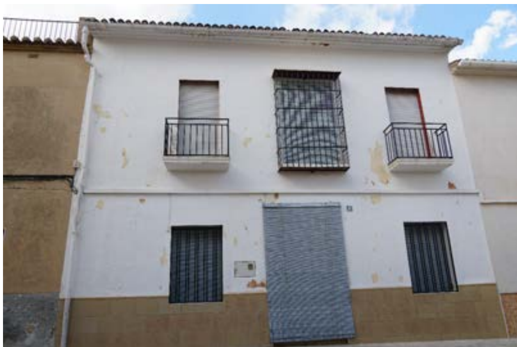
5. FOTO 1. Vista frontal fachada
