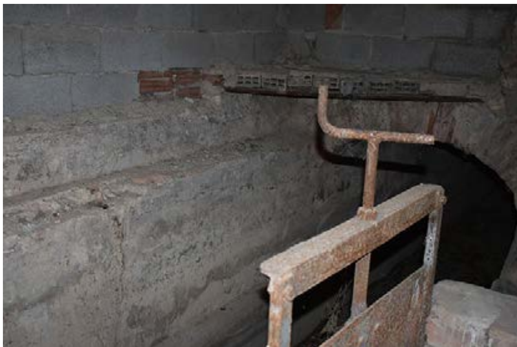
9. FOTO 5. INTERIOR DESVIADOR Y CÁRCAVO
