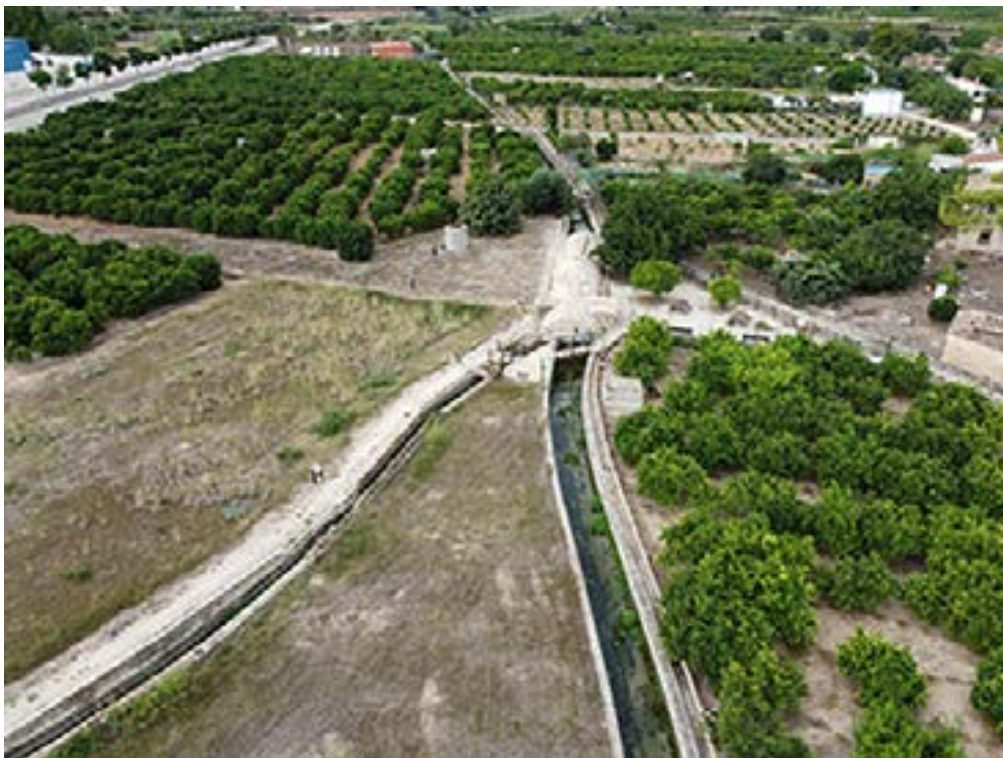
6. FOTO 2. VISTA AÉREA
